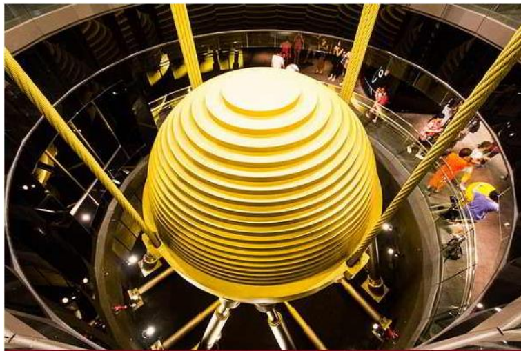
شکل ۲۰-۲ میراگر پاندولی جرمی به کار برده شده در تایپه ۱۰۱
